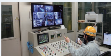
配合室にある画面から地金が保管されているコンテナを確認し、地金の投入を行う。
